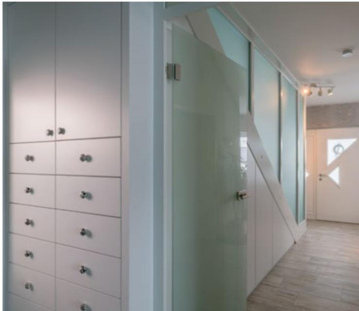
Wangentreppe COMFORTLINE mit RAL lackierten Wangen und ROBUSTPLUS-Stufen in Schiefer-Optik, Abtrennung des Treppenraumes durch Glasraumteiler mit satinierten Glas und Schrankanlage unter Treppe
