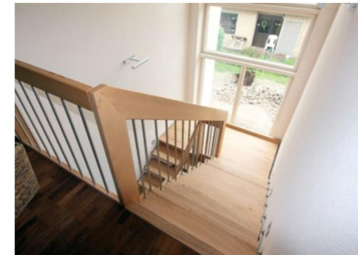
*BASICLINE in Holzart Buche Rotkern mit lackierter Oberfläche, Ausführung der Treppe als Podesttreppe mit Geländerstäben aus Edelstahl, BA044*
