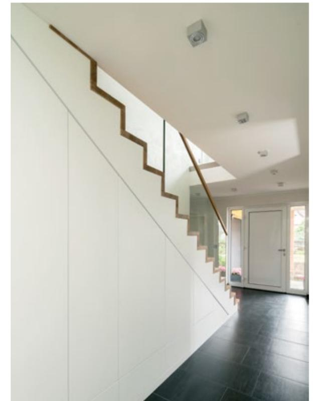
Aufgesattelte FALTWERK-Treppe mit weißen Wangen und Stufen in Eiche dunkel geölt, Geländer als Flachstahlgeländer mit Griffleiste in Eiche, der Stauraum unter der Treppe wurde für Schränke genutzt die nahtlos in die Garderobe übergehen
