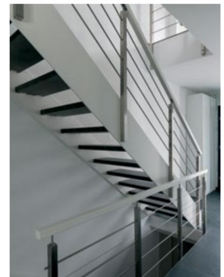
STEELLINE-Treppe als gerade Treppenanlage mit Quadratpfosten aus Edelstahl sowie Relinggurten aus Edelstahl, Stufen aus ROBUSTPLUS Schiefer
