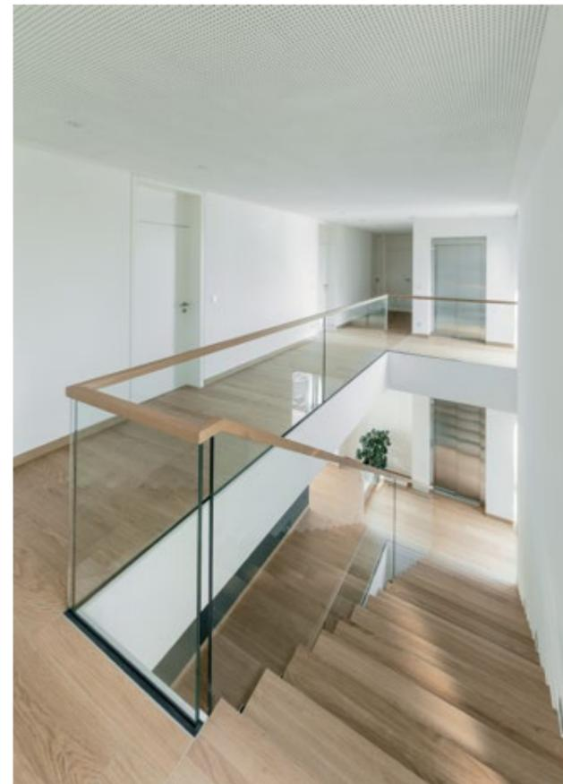
*KRAGWERK-Treppe aus Eiche MB mit geölter Oberfläche, seitliche Verglasung über Punkthalter aus Edelstahl, Brüstungsgeländer als eingespannte Verglasung mit Bodenleiste, Handlaufleiste Eiche MB geölt*
