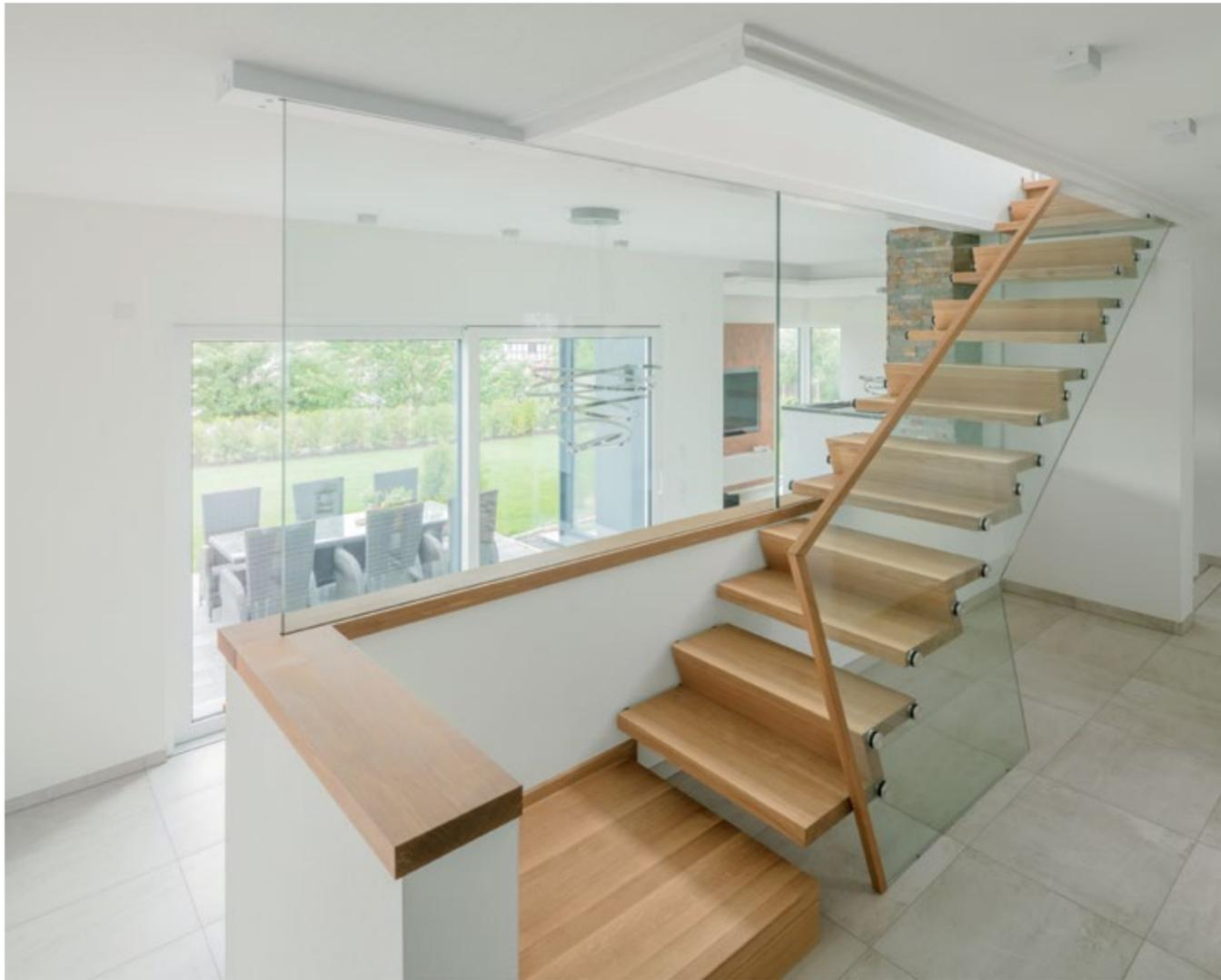
*KRAFA-Treppe in Eiche gefertigt, Oberfläche geölt, Brüstungsgeländer als eingespannte Verglasung*
