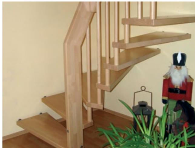
*BASICLINE in Holzart Buche Parkett A-Sortierung, Oberfläche 3-fach lackiert, Geländerstäbe aus Buche gefertigt, Tragbolzen zwischen den Stufen aus Buche gefertigt, BA091*
