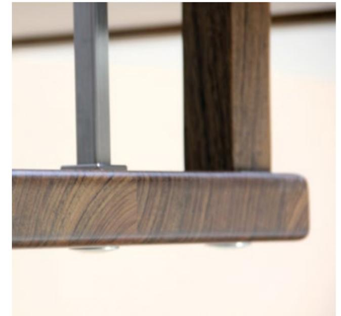
*BASICLINE-Treppe aus Buche kgz, Oberfläche geölt, Pfosten 44x160mm, Distanzen zwischen den Stufen aus Buche 40mm, Stäbe als Holz-Edelstahl-Kombination, E2*
