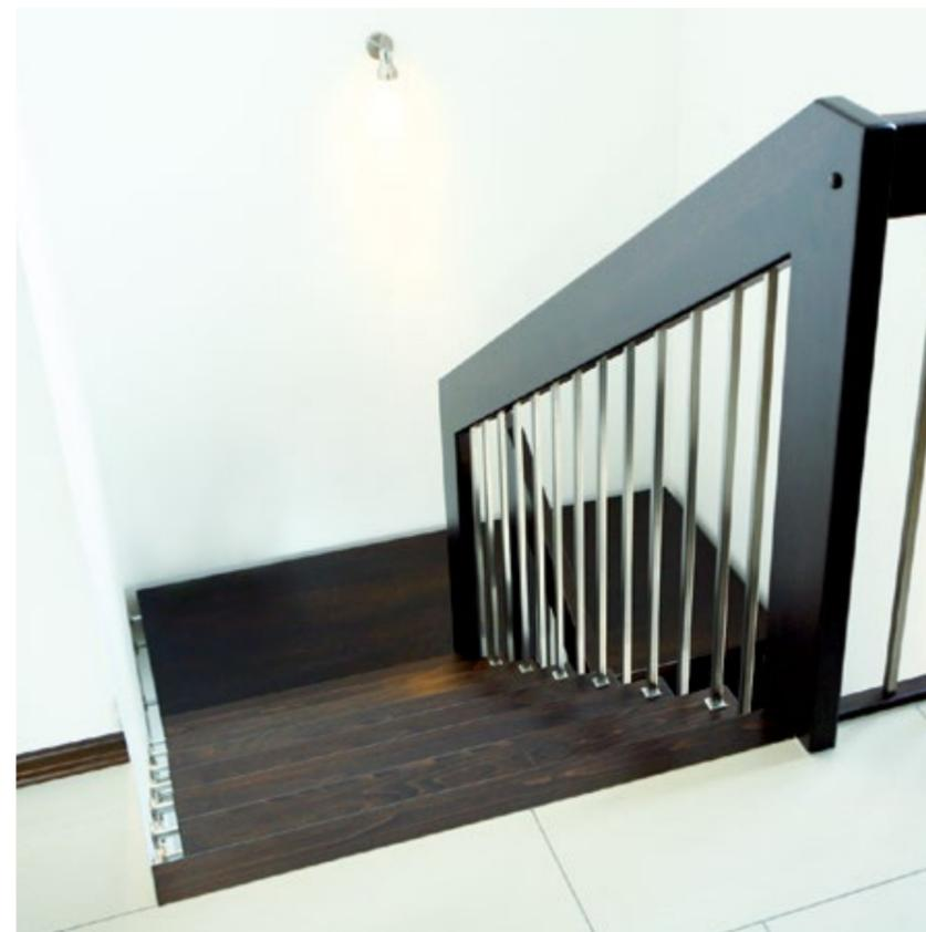
*Markantes Detail: die Austrittsposten in 45 x 160 mm mit seitlich angeschlossenem Brüstungsgeländer, BA007*
