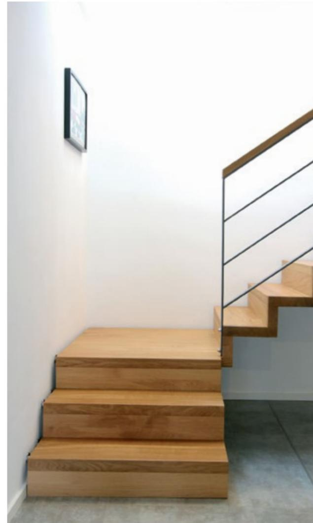
*FALTWERK in Eiche durchgehende Lamelle blockverleimt, Oberfläche geölt, Geländer als Flachstahlgeländer mit Griffleiste aus Eiche, FA058*
